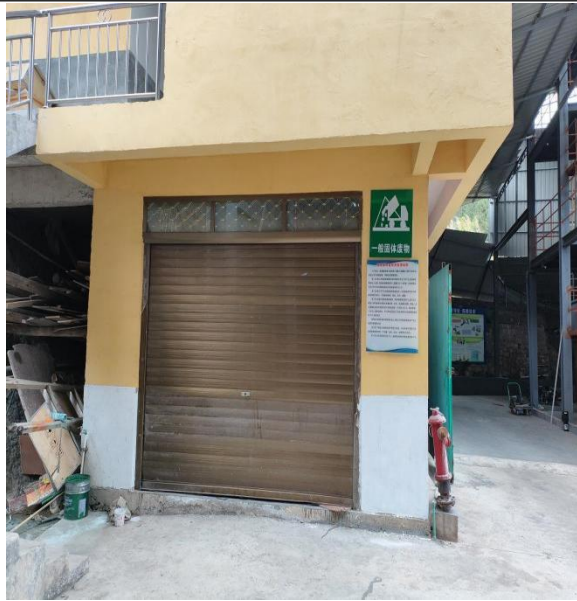
一般固废暂存间
